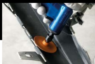
Шлифование внутренней стороны при помощи Hamach HP 80 и Colad Spin & Trim.
